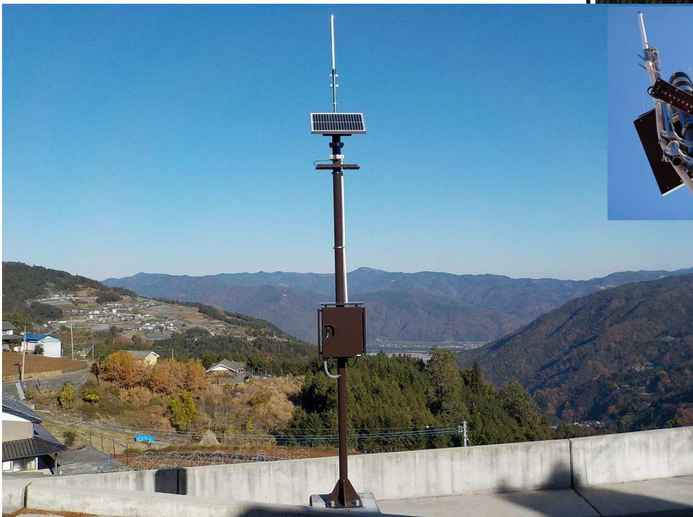
太陽電池で発電した電力を蓄電池に充電し、非常時にはAC100Vを使用することができます。本設備は孤立可能性集落に配置して、緊急時にデジタル簡易無線の充電と遠距離の災害対策本部との連絡を可能にできるように中継アンテナを設けています。(アンテナ本体及び取付は範囲外)
